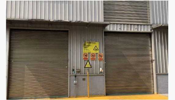
危险废弃物仓库
